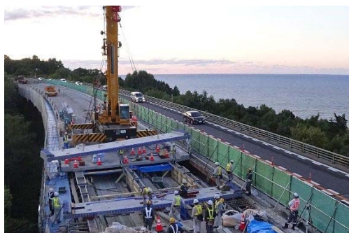
札幌道 大野橋床板取替工事
