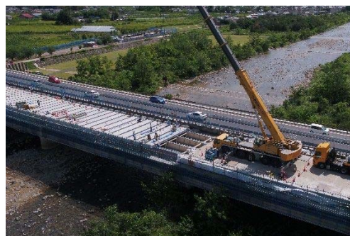
東北道 吾妻(あずま)橋床板取替工事
